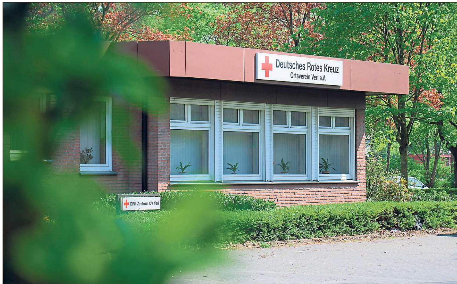
Gibt die Politik grünes Licht, dürften die Tage des DRK-Gebäudes an der Ecke von Bahnhofstraße und Österwieher Straße gezählt sein. Dort soll ein Neubau mit Wohnungen für junge Menschen mit Behinderung entstehen. Bilder: Ackfeld
